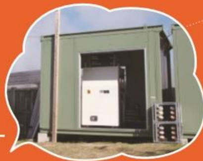
小浜温泉の足湯に設置した新設備 「可搬型小型発電システム」
