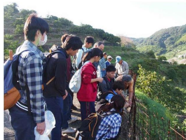
防護柵の補修（諫早市多良見町ミカン園内）
